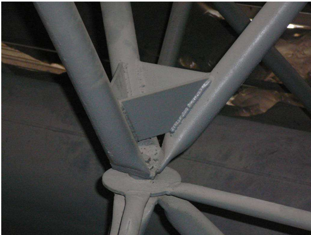
Foto 3 Detail styčnicku s patrným zesílením – vzájemným propojením diagonálních prutů (horních jehlanů). Spojky byly použity zřejmě pro zkrácení vzpěrných délek prutů.
