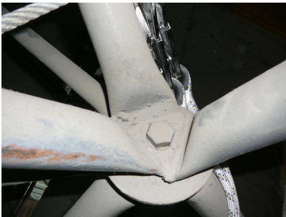
Foto 2 Detail styčnicku s patrným znatelným excentrickým připojením diagonálních prutů, drobná lokální povrchová koroze.
