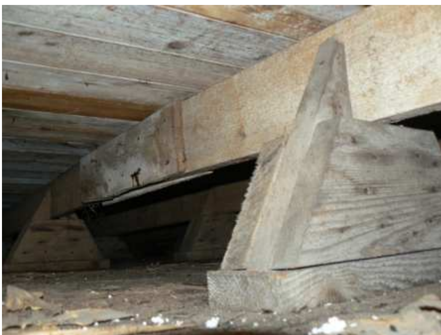
Foto 10 Konstrukční řešení dřevěné části střechy nad izolačním panelem JRD Nemšová
