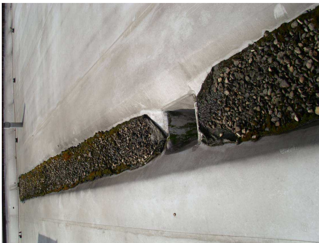
Foto 18 Detail řešení střešní vpusti
