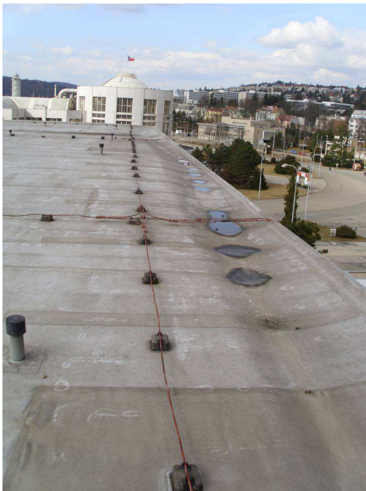
Foto 25 Špatné spádování střechy v okolí štítových stěn – napojení hřebene na zbytek obvodové stěny beze spádu.
