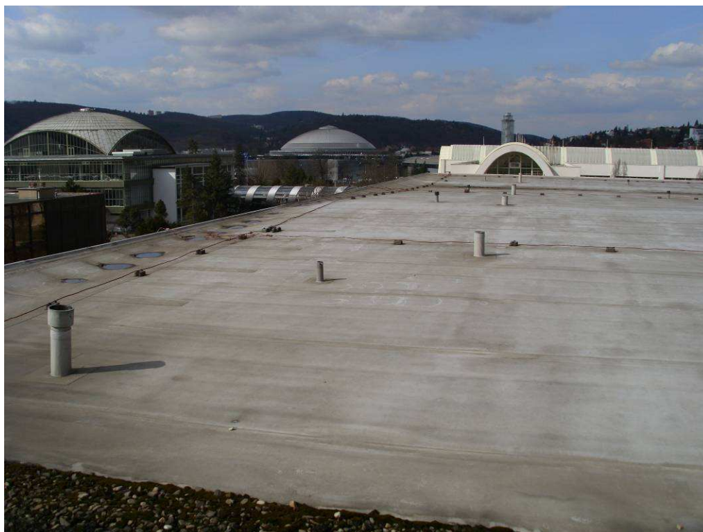
Foto 19 Stav vyústění instalací nad střechu – chybějící stříšky komínků apod.
