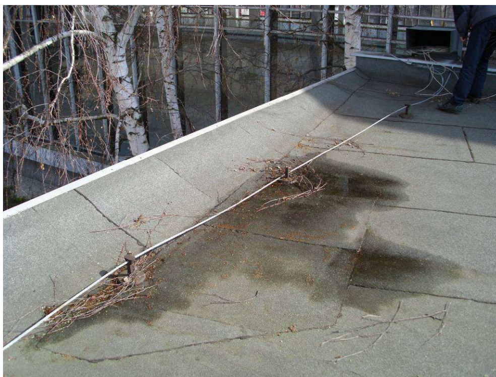
Foto 39 Vadné spádování střechy vstupního objektu
