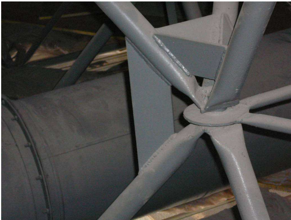
Foto 5 Detail styčnicku s patrným zesílením – vzájemným propojením diagonálních prutů (horních jehlanů a diagonálních prutů dolních jehlanů), zřejmě pro zkrácení vzpěrných délek prutů.
