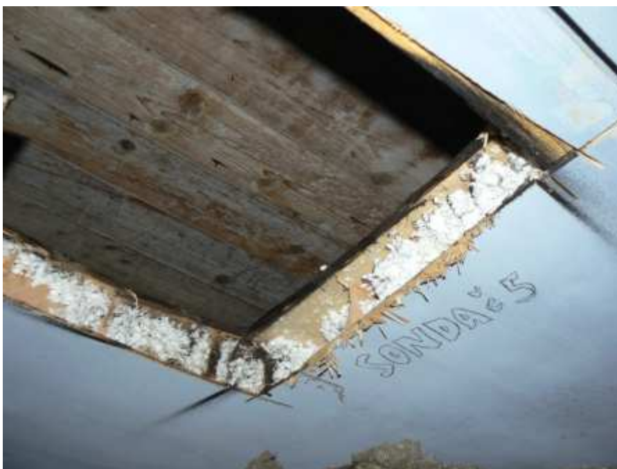
Foto 12 V detailu sondy je patrná konstrukční skladba izolačního panelu JRD Nemšová
