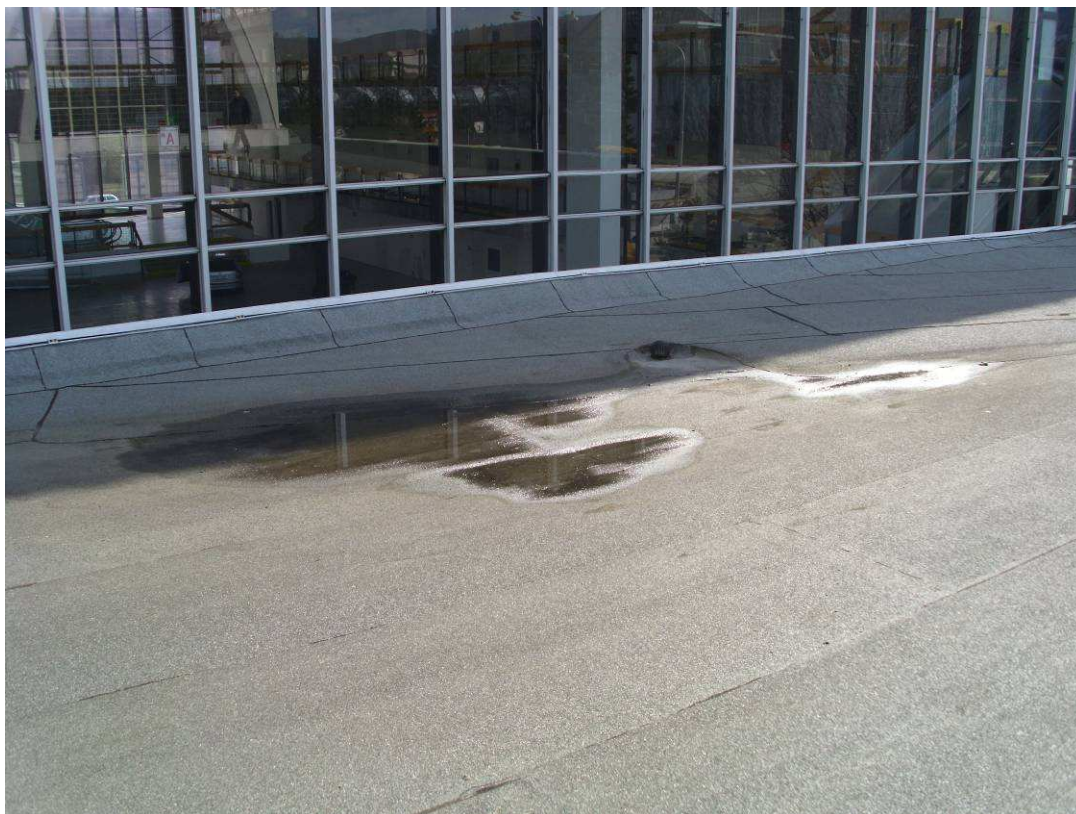
Foto 38 Vadné spádování střechy vstupního objektu
