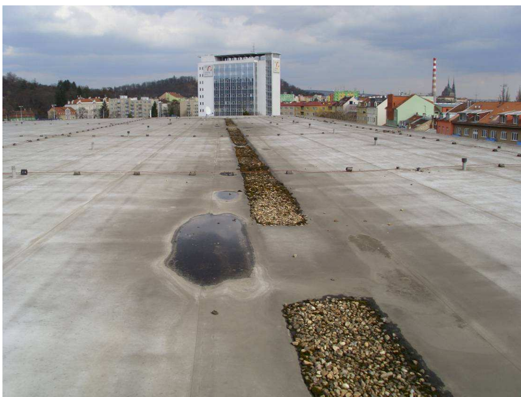
Foto 24 Špatný spád v rozvodí podélných střešních žlabů
