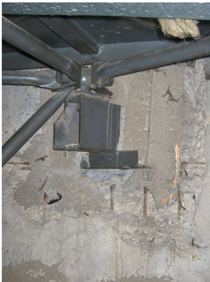
Foto 30 Nedokonalé přibetonování nosné stěny v oblasti uložení střešní konstrukce
