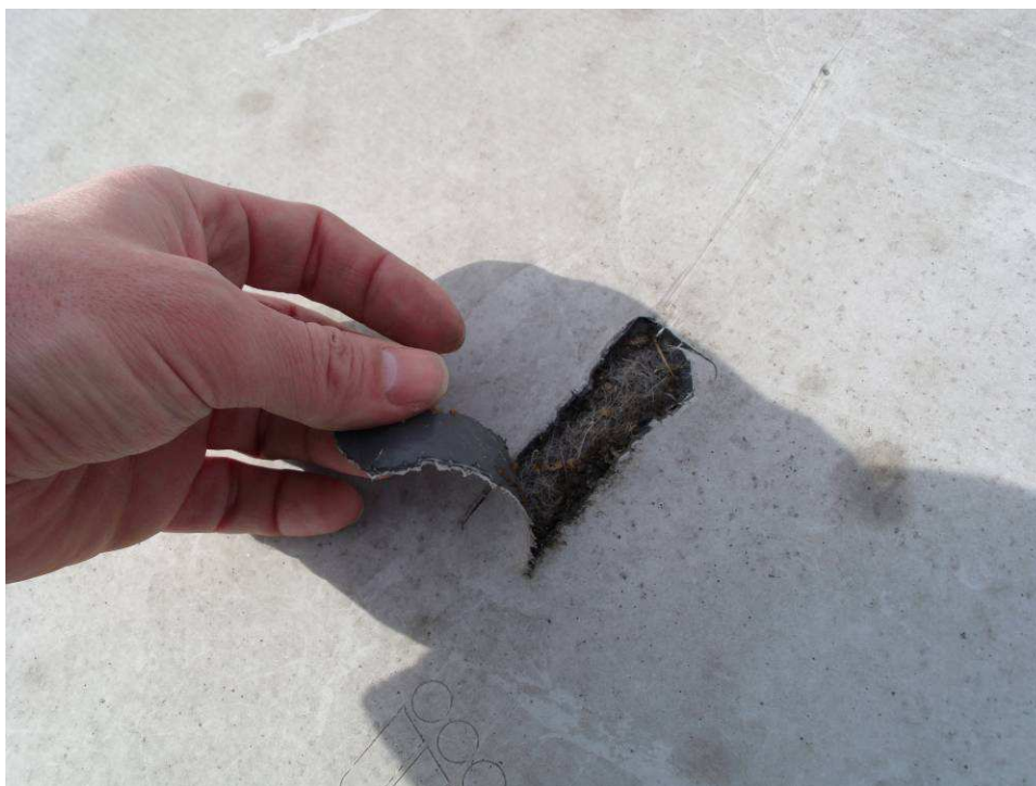
Foto 21 Mechanické narušení fóliové hydroizolace střechy
