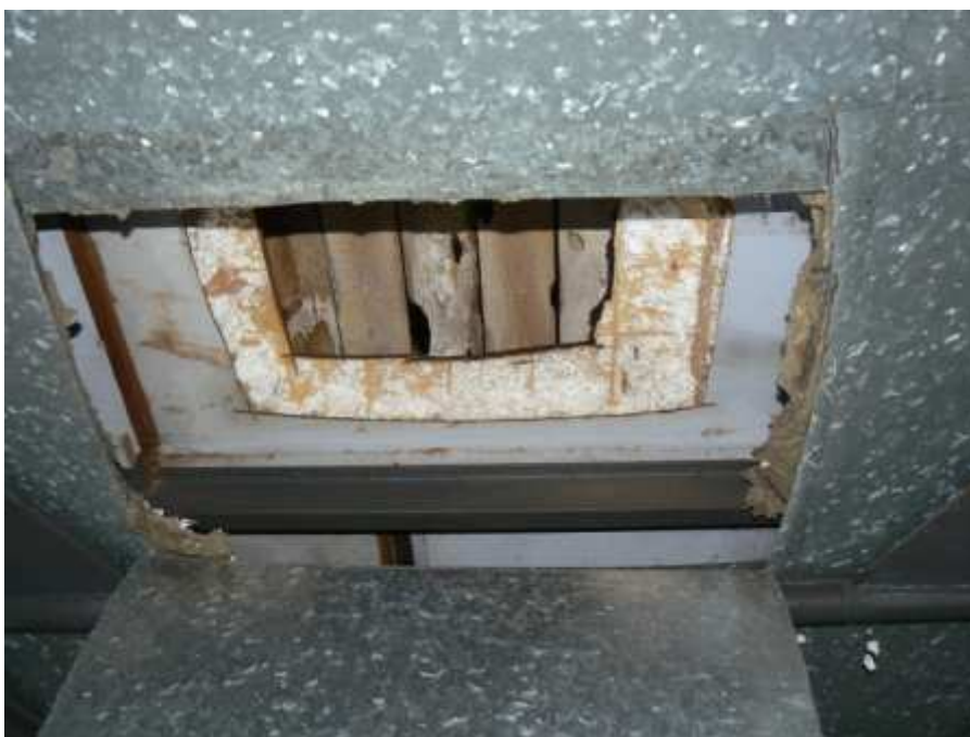
Foto 31 Sonda do střešního pláště – viditelná celá skladba – pozinkovaný plech, dodatečná izolace vatou, původní izolační panel JRD Nemšová, bednění
