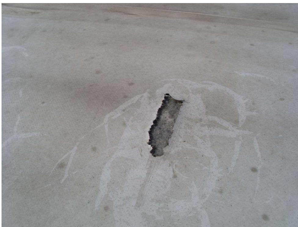
Foto 20 Mechanické narušení fóliové hydroizolace střechy
