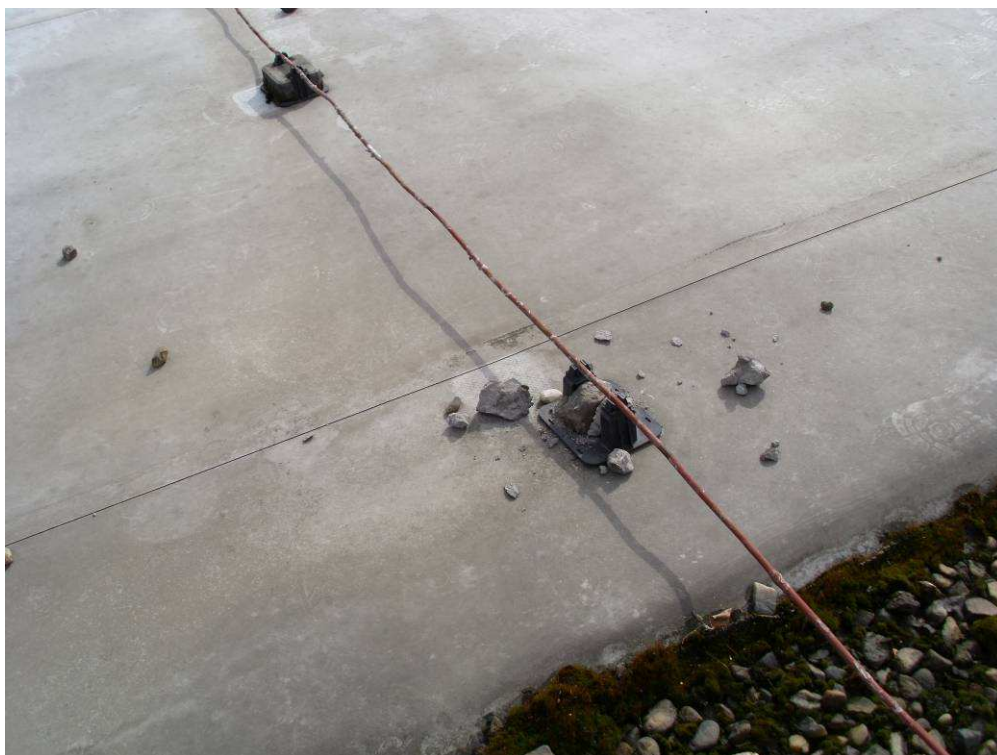
Foto 22 Rozpadané držáky hromosvodného vedení
