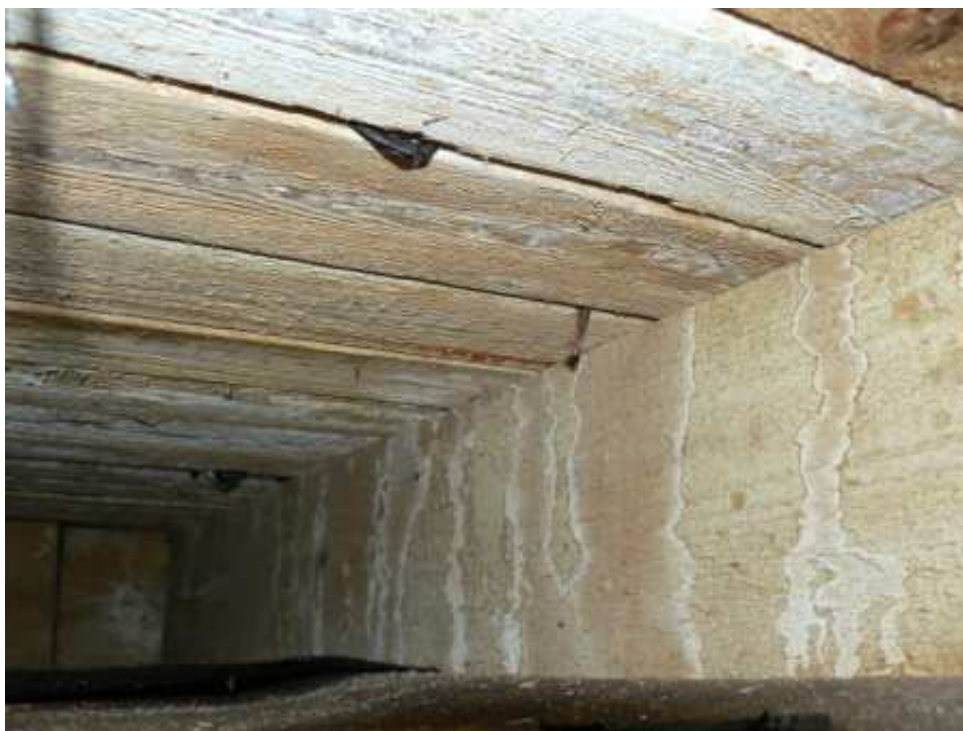
Foto 32 Stopy po zatékání na krokvích a záklopu
