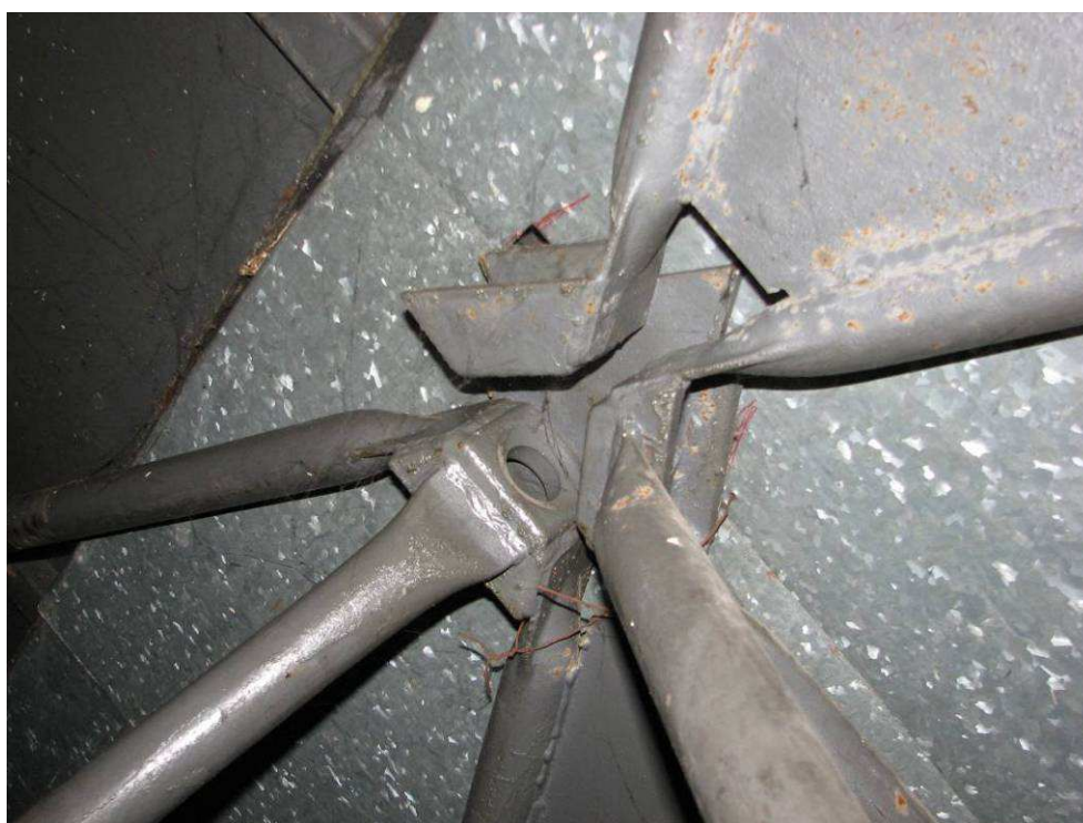
Foto 29 Pohled na krajní styčník horní roviny desky. U části styčníku střechy nejsou osazeny spojovací soudky. Spojení prutů je zajištěno pomocí rámových spojek z plechu, geometrie není přesná, tzn. některá zakončení prutů jsou osazena mimo horizontální pozici.
