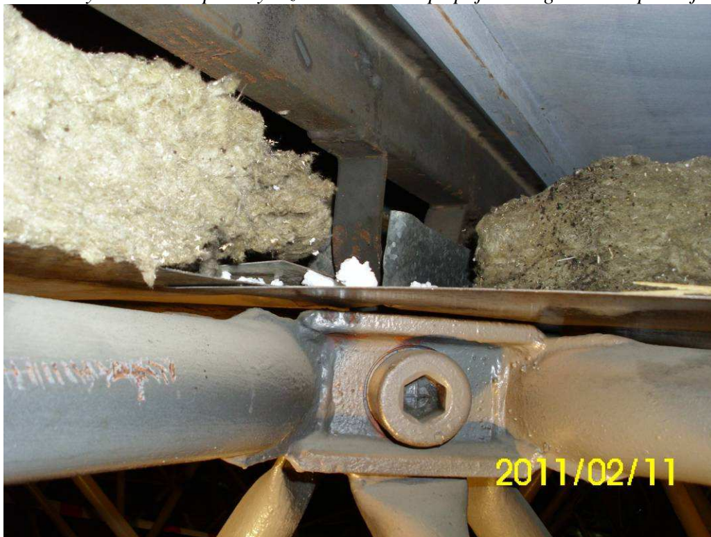
Foto 8 Konstrukční řešení nad rovinou horních styčnicků – ocelová tenkostěnná vaznice a izolační panel JRD Nemšová
