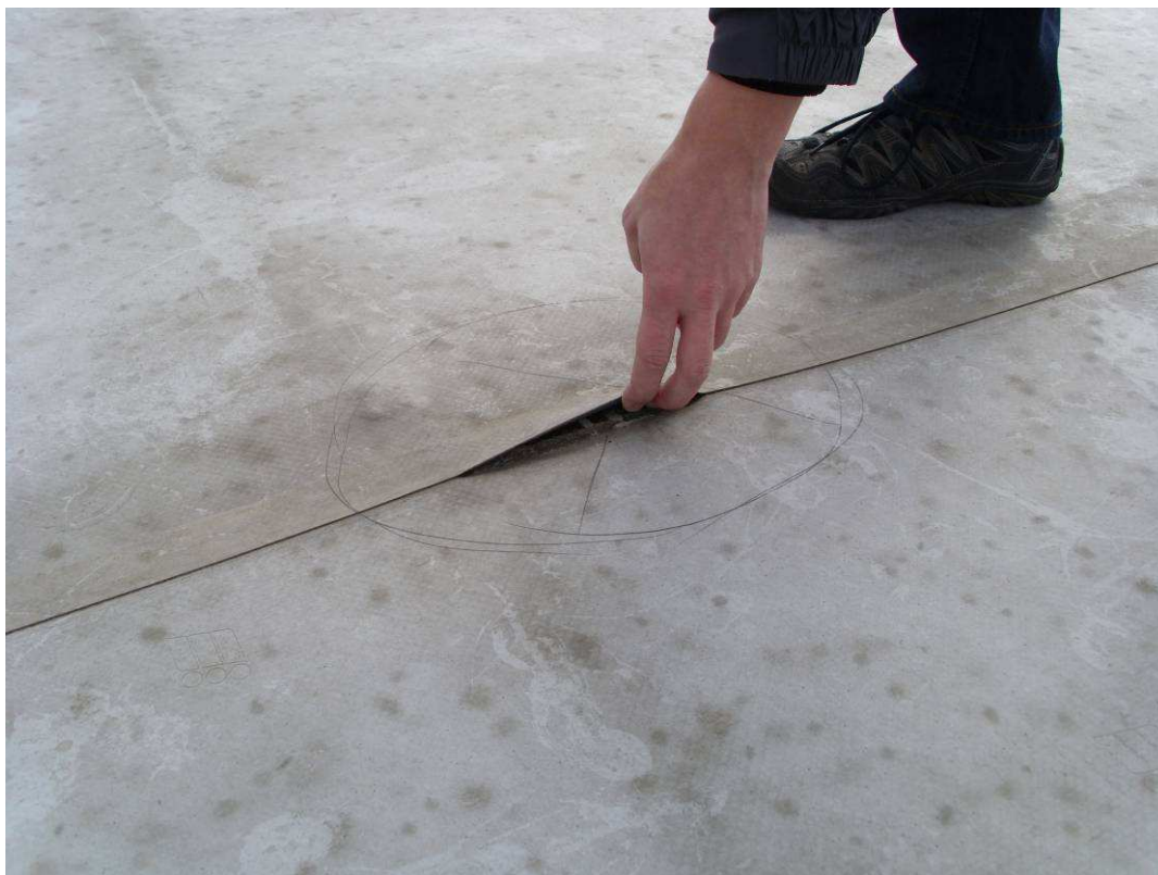
Foto 23 Netěsné spoje fóliové hydroizolace
