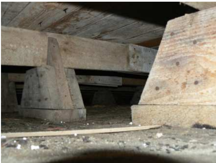
Foto 11 Osazení krokví na „kozlíky“ různé výšky zabezpečuje požadovaný sklon střechy
