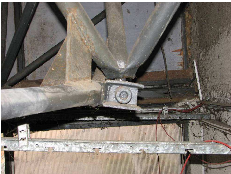
Foto 27 Styčník dolní roviny – je patná lokální povrchová koroze prutů a zejména nepřesná geometrie soustavy, která vznikla (a je fixována) již při montáži konstrukce.
