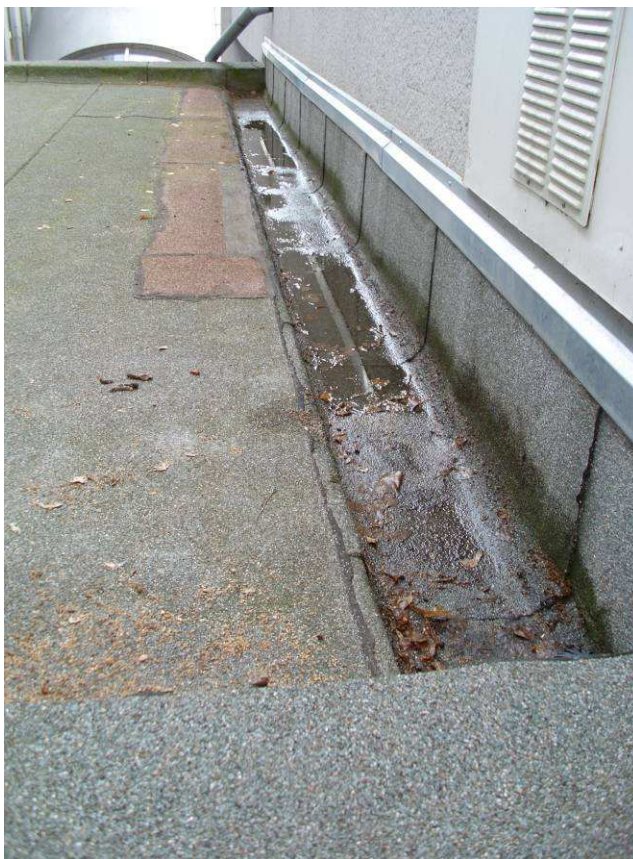
Foto 34 neodtékající voda v zaatikovém žlabu střechy krčku mezi hlavním a vstupním pavilonem
