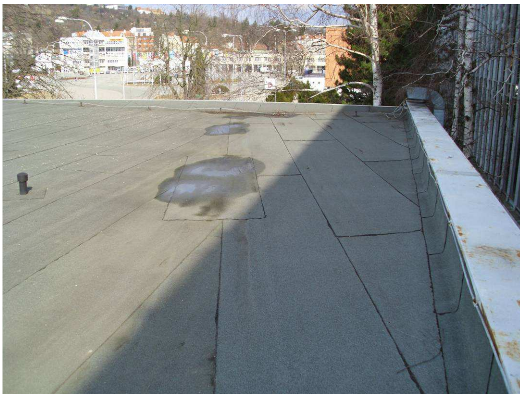
Foto 37 Vadné spádování střechy vstupního objektu
