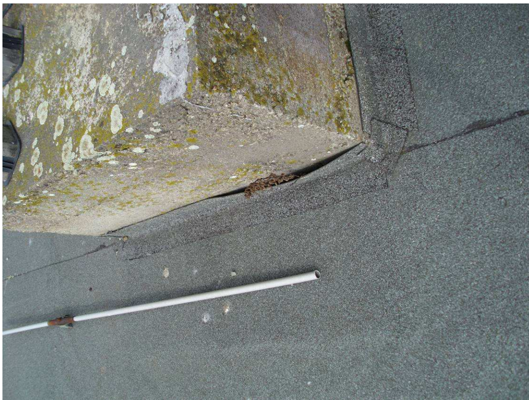
Foto 15 Netěsnosti v detailech hydroizolace střechy výtahu
