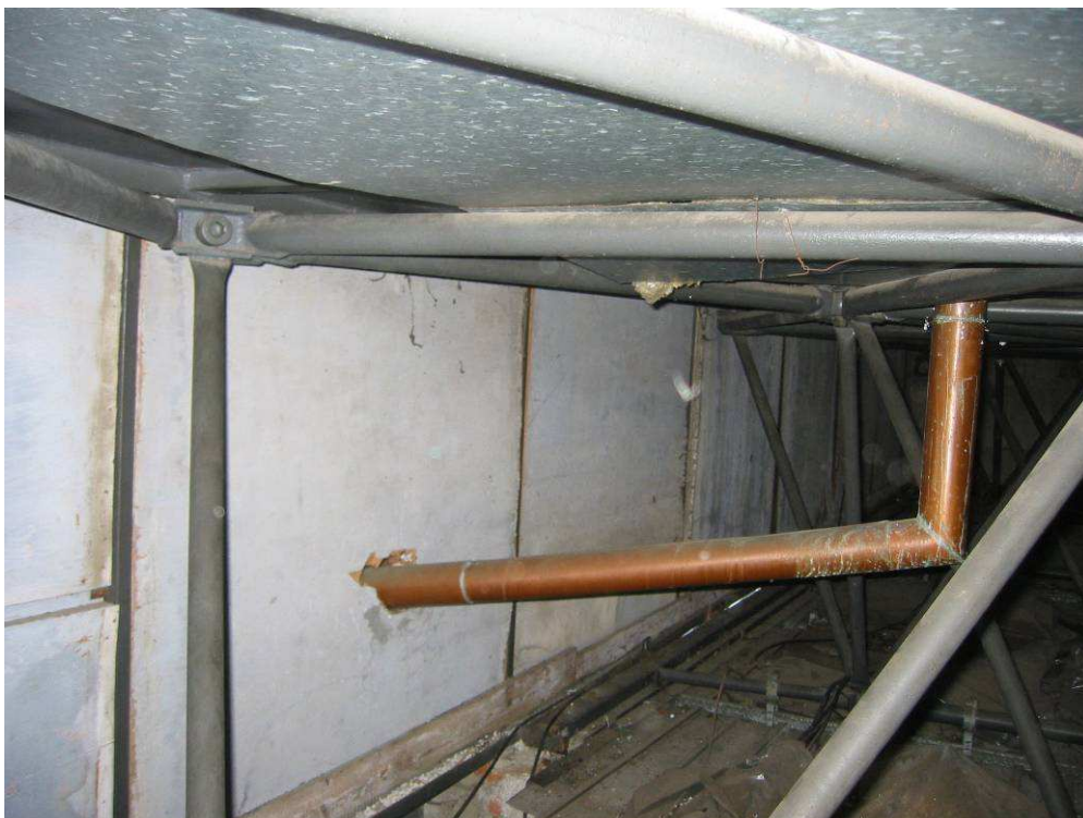
Foto 36 Dodatečně zřízené odvodnění střechy vstupního objektu
