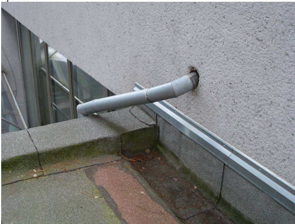
Foto 35 Dodatečně zřízené odvodnění střechy vstupního objektu
