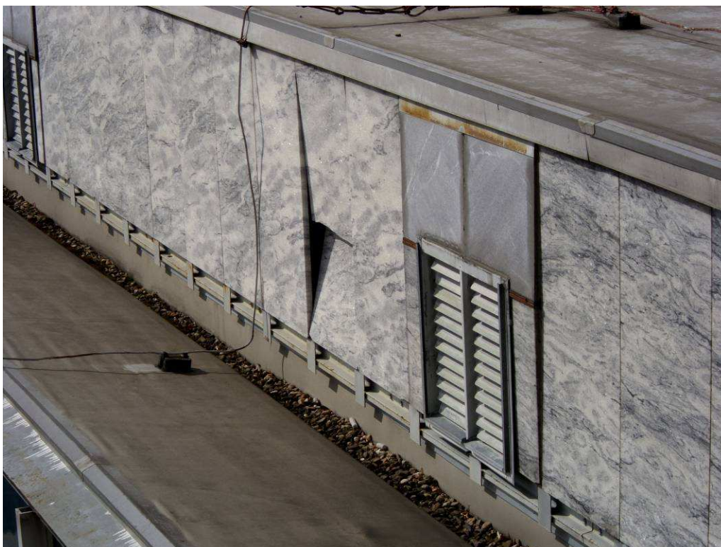
Foto 17 Narušení kamenných obkladů
