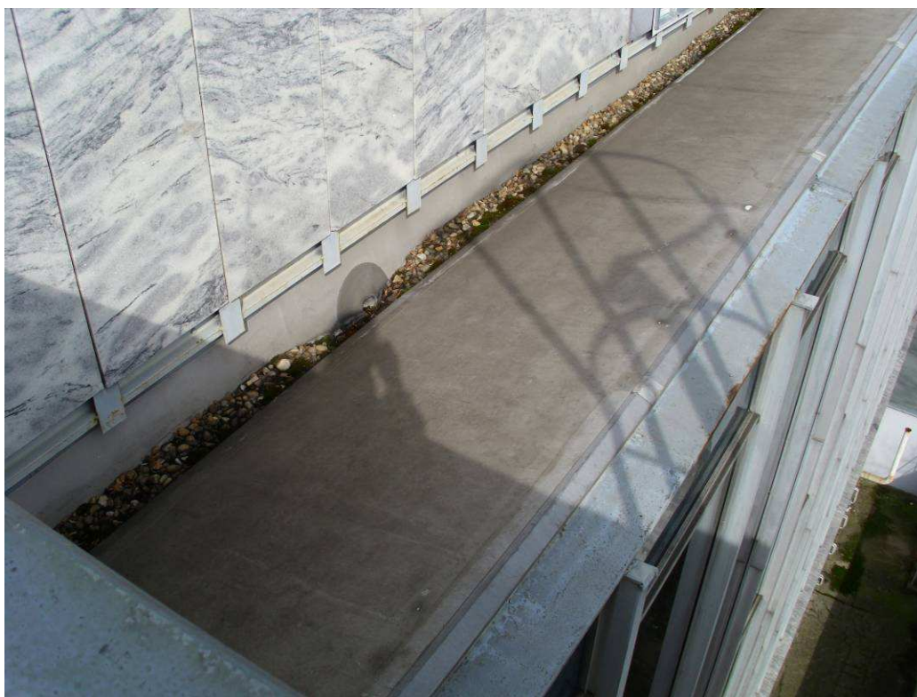
Foto 16 Snížená část zastřešení nad obvodovým pláštěm – zaatikový žlab s vpustí
